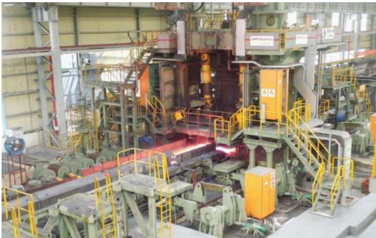
Vorgerüst R2 mit Staucher.
