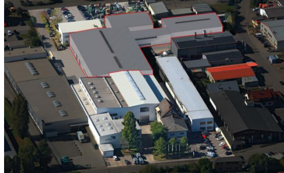
Planungsanimation: Der rot umrandete Bereich zeigt die geplanten neuen Logistik- und Fertigungshallen der HERBOLD Meckesheim GmbH. (Grafik: HERBOLD)
