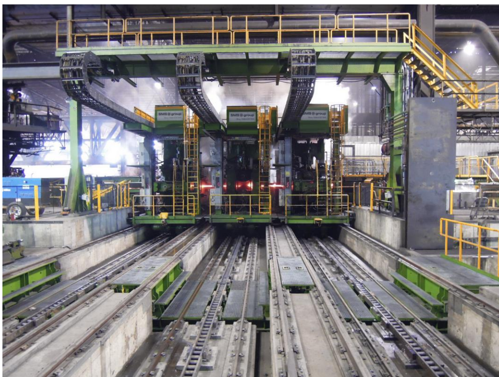
CCS ® -Tandemgruppe einer vergleichbaren Anlage.
