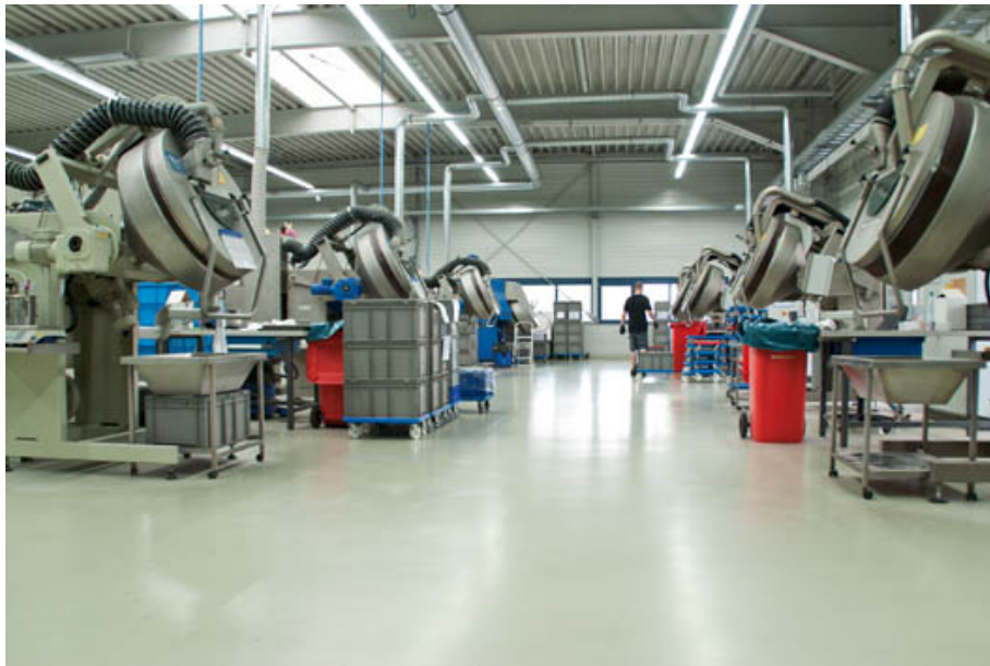
Bild Nr. 14-01 OE_Beschichtungszentrum.jpg. OVE Plasmatec verbessert die Luftqualität in seinen Produktionsräumen. Drei neue Entstaubungsgeräte schaffen Reinraumqualität.
