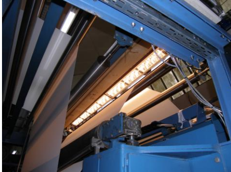
Abbildung: Installierte Prozesskontrolltechnik in einer Textilveredelungsanlage zur In-line-Überwachung (Bahnbreite und -länge = 3.6 x 70 m). (Bild: Dr. O. Daikos, © IOM)
