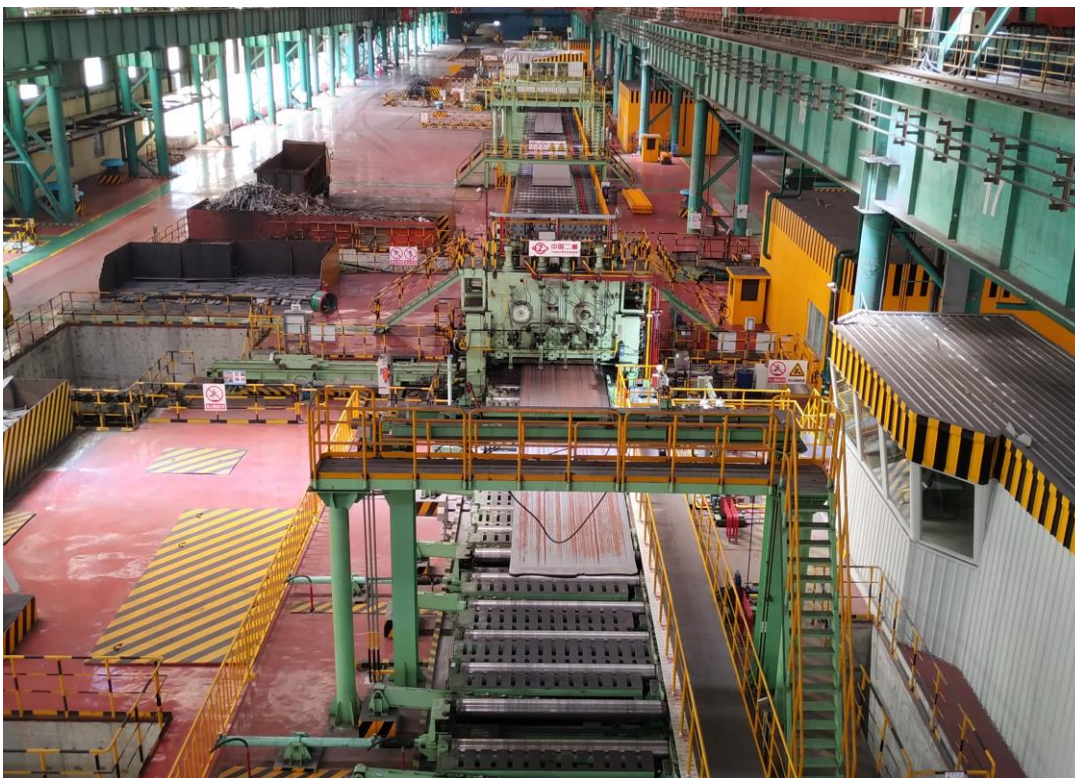
Die von der SMS group modernisierte Scherenlinie Nr. 2.
