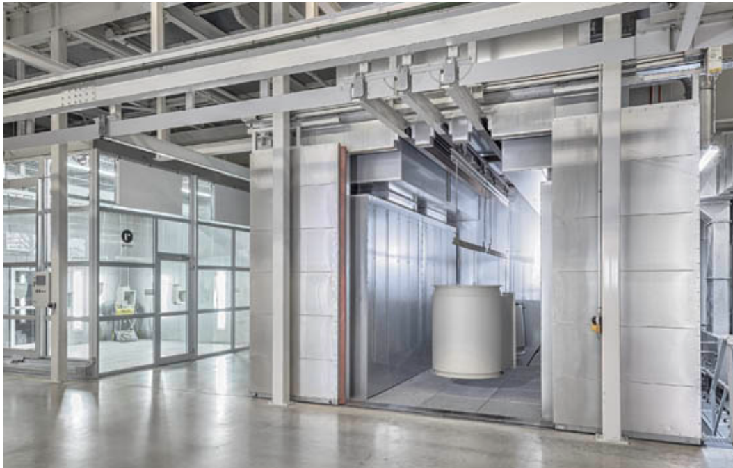
Bild Nr. 14-03 KY_PB-Anlage.jpg.
